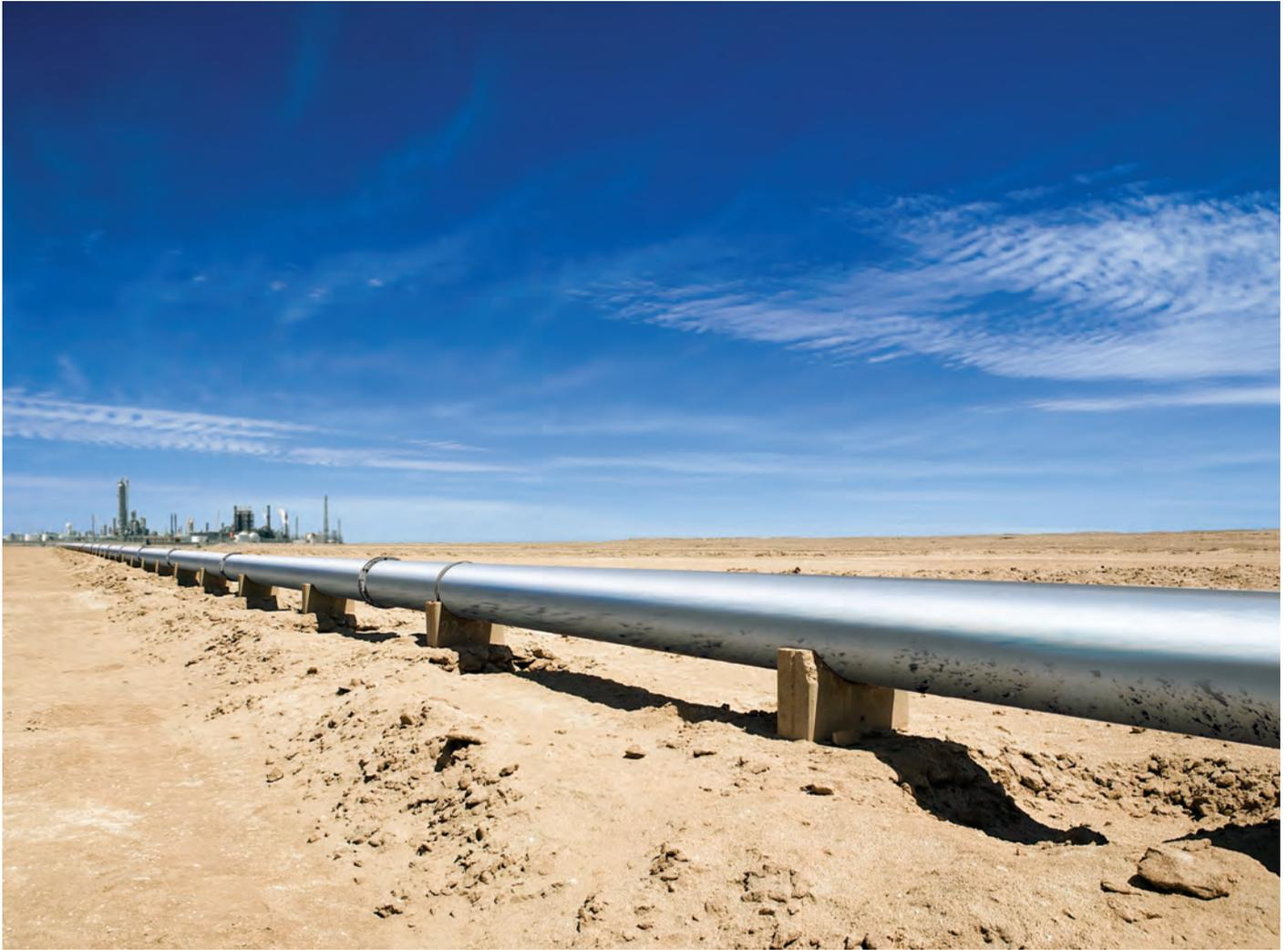
科模热思集肤效应电伴热对于防冻保护，保温以及长距离(长达25公里)原料输送管道加热是非常理想的。它适用于地面或地下，浸在水里，乃至穿越各种地形的管道。它应用于诸如化工、石化、炼油、以及天然气行业的油库和油罐区与远端处理设备之间的原料传送管道。集肤效应电伴热系统使用单回路，避免了复杂的电源供应系统，这使其相比传统的伴热方案极具成本效益，尤其是对于需要高昂维护成本的边远区域。
